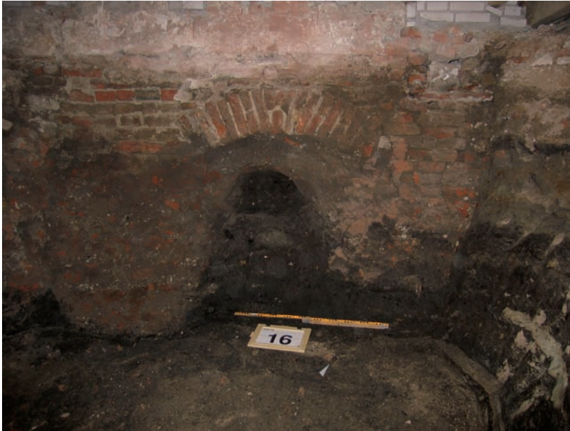
Afb. 9. Spaarboog in fundament.
